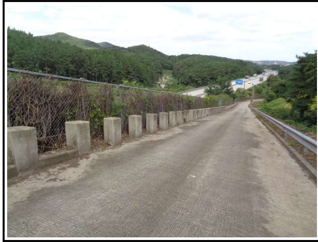
【그림 5.3.1】 상부자연사면 전경
