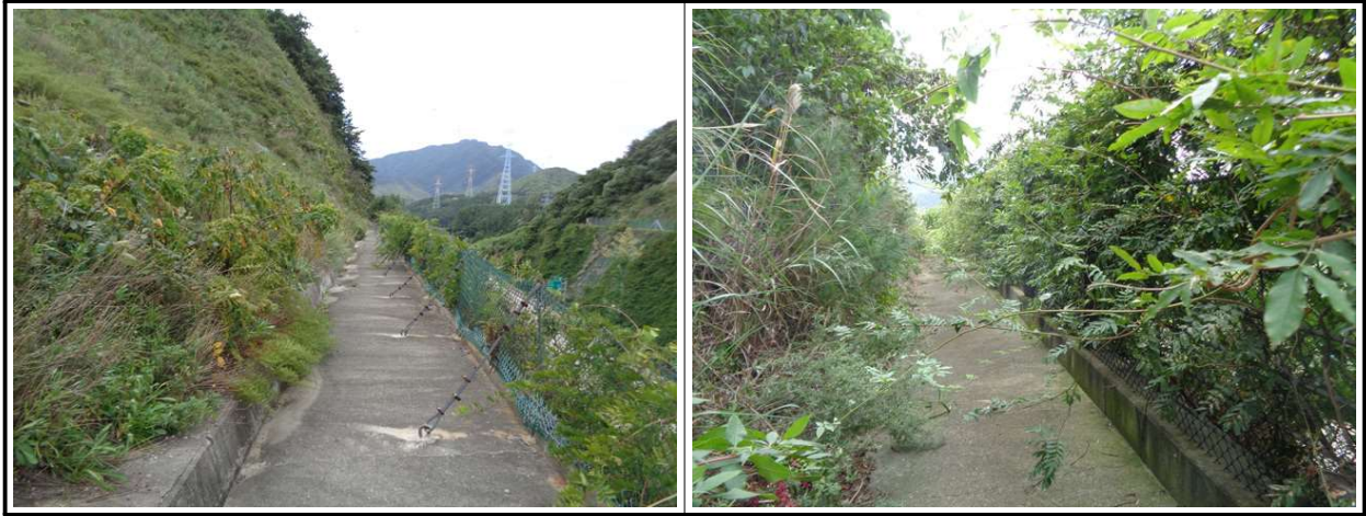
【그림 5.3.3】 배수시설 전경
